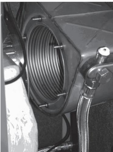
Jetzt ist es möglich den Wärmetauscher von Innen zu besichtigen und zu reinigen.
