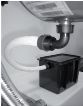
Kondensatschlauch von der Kondensatbox entfernen
