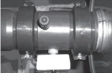
Für die Demontage des Wärmetauschers lösen Sie bitte die beiden Flanschschellen rechts und links vom Abgastermostaten. Dieses Teilstück lässt sich nun problemlos entfernen.
