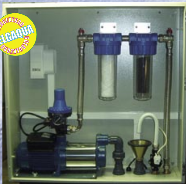
Het interieur van de fraai ingerichte ERCU Regenwaterbeheerssysteemkast.
